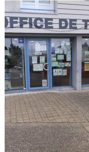
**Constat Entrée Principale :** L'entrée principale est facilement repérable, il y a une signalétique. Devant la porte d'entrée, une partie du cheminement extérieur est en dévers. Il y a un seuil de 2cm à angles droits.
